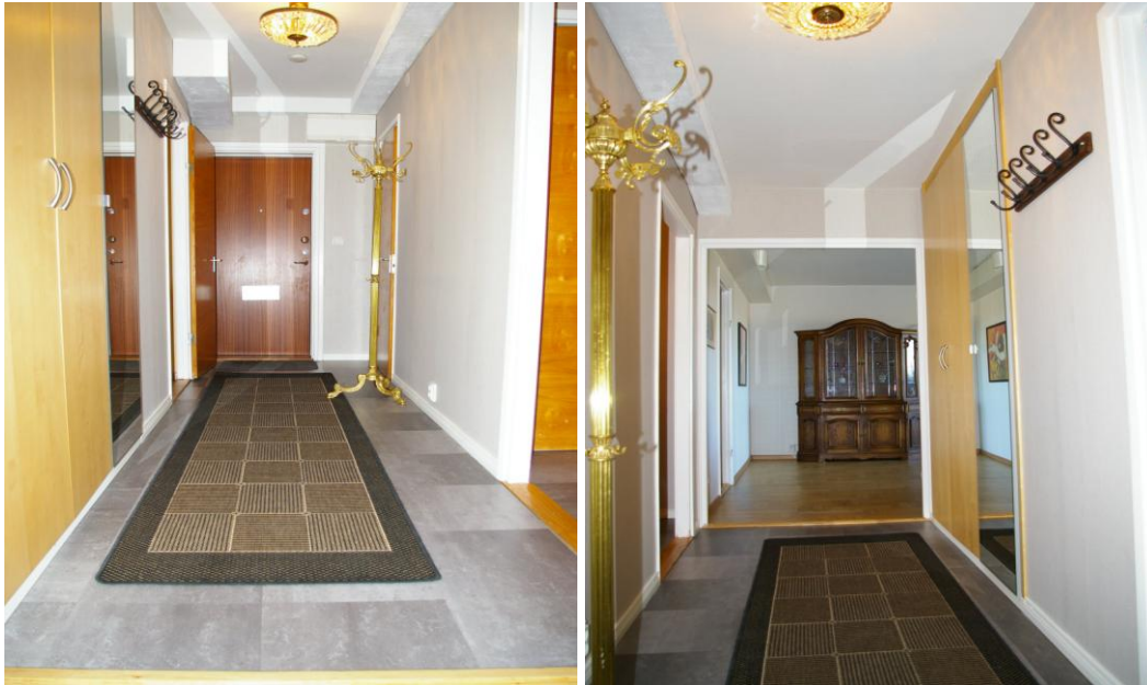
Figur 4.7 Ventilationskanaler i halltak efter ombyggnad med FTX-system. Foto: ERA Bomäklarna
