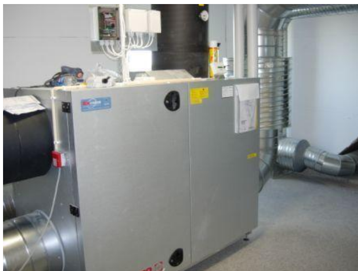
Figur 4.5 Centralt FTX-aggregat i apparatrum på vind. Foto: GEA Exhausto
