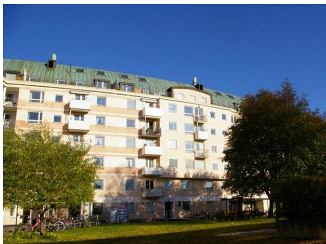
Figur 4.4 Bostadsrättsföreningen Bågen i Umeå där centrala FTX-system installerats.
