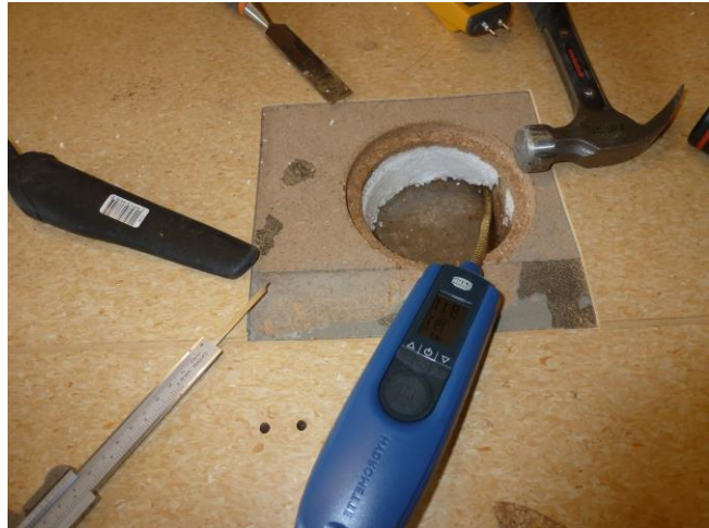
Figur 12. Mätning av fukt inne i övergolvs konstruktion
