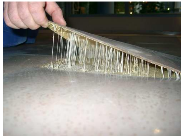
Figur 2. Så här kan fuktpåverkat golvläm se ut
