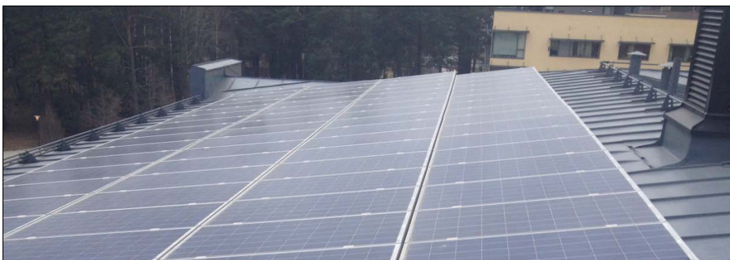
Paneler monterade parallellt med taklutningen
