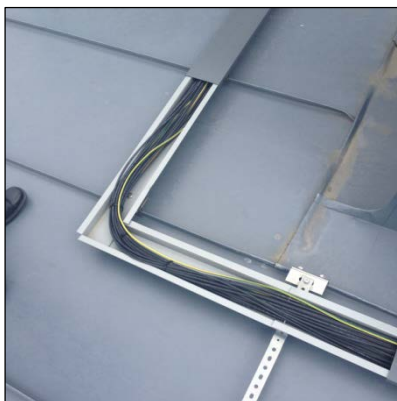
Exempel på regnskyddad kabeldragning
