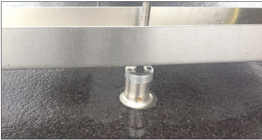
Förankring i takkonstruktionen
