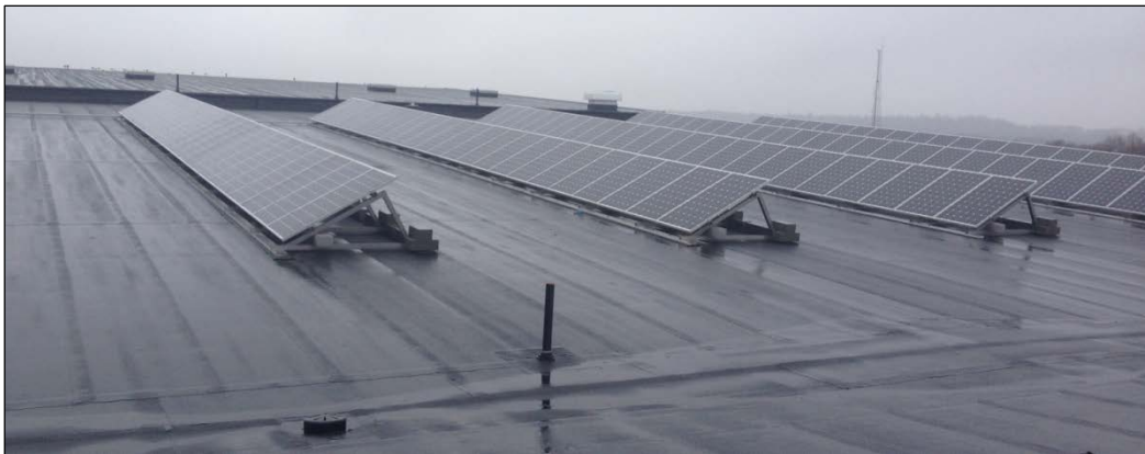
Exempel på ballastförankring vid vinklad montering
