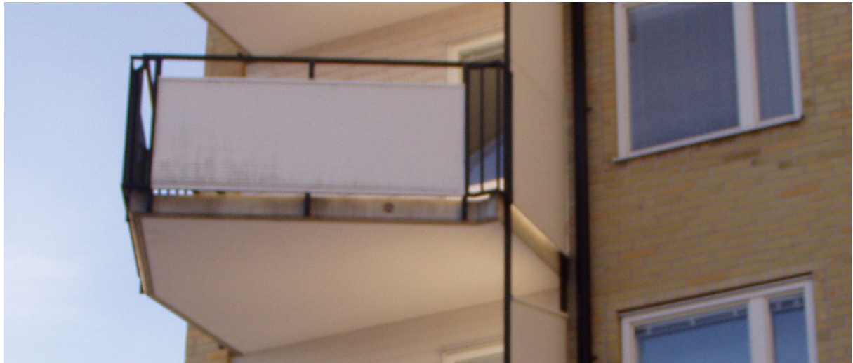
Figur 5.1. Exempel på balkong med betonggolv i byggnad från 1994.
