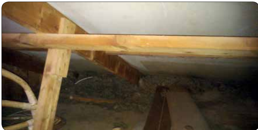
Vindisolering som genom åren blåst till hörnet – där gör den ingen nytta.
