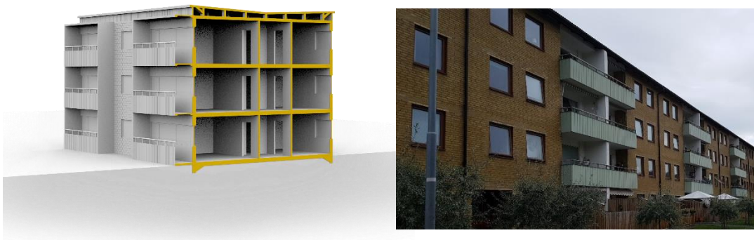
Figur 4.3 Exempel på typflerbostadshus från 70-talet: ett trevåningslamellhus (Skiss: Boid, Foto: CIT Energy Management).
