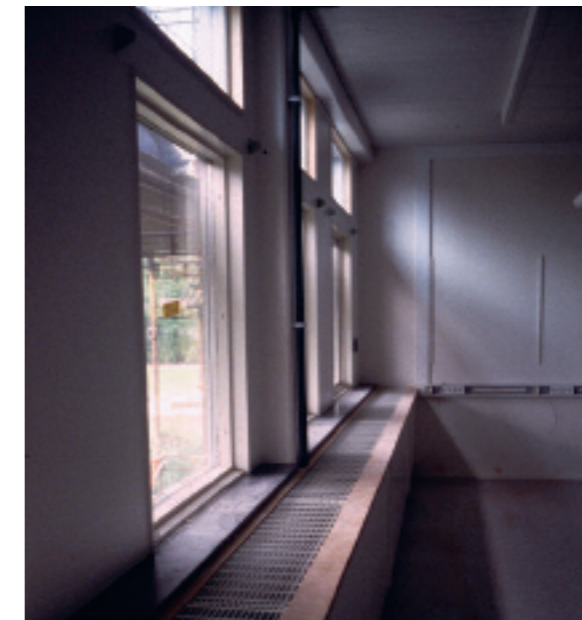
Exempel på luftintag i ett hybridventilationssystem där luften förvärms med konvektorer i fönsterbänken. Endast ett galler utan tryckfallsförlust täcker luftintaget och intagen är riktade rakt uppåt för att undvika drag.
