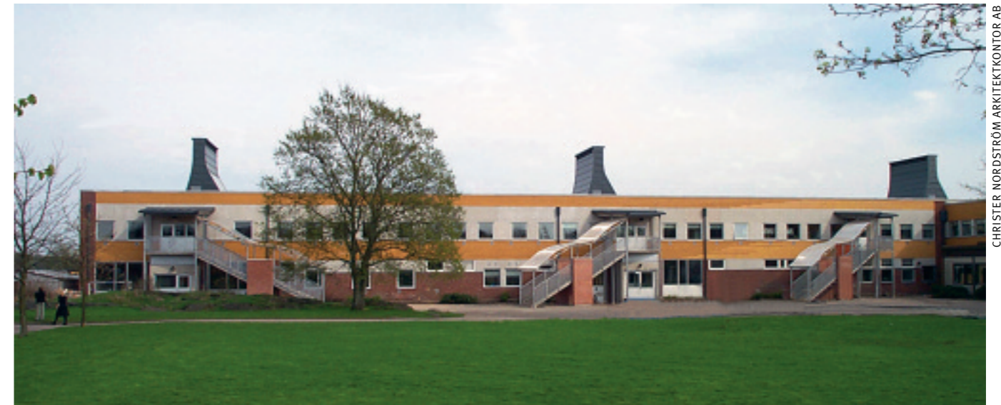
Tångaskolan med de karakteristiska solskorstenarna på taket. Skorstenarna ökar självdragskrafterna och reducerar därmed behovet av fläkt drift, både antal drifttimmar och eleffekt.
