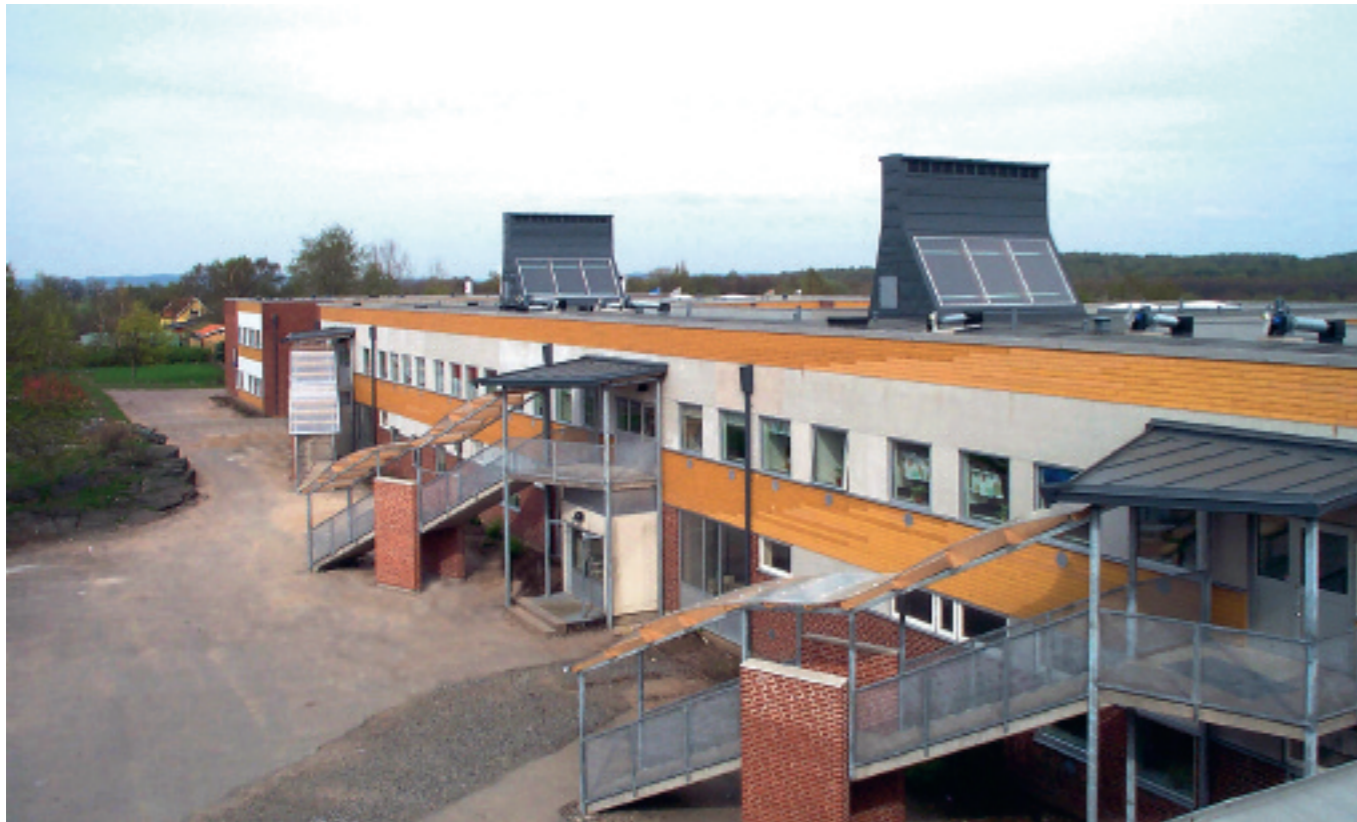
En av tre klassrumslängor i Tångaskolan med hybridventilation. På toppen av byggnaden syns solskorstenen och under varje fönster skymtar öppningarna för tilluften. Varje självdragsskorsten betjänar en flygel med sex klassrum och några grupprum. Totalt ventileras tre flyglar med detta ventilationssystem.
